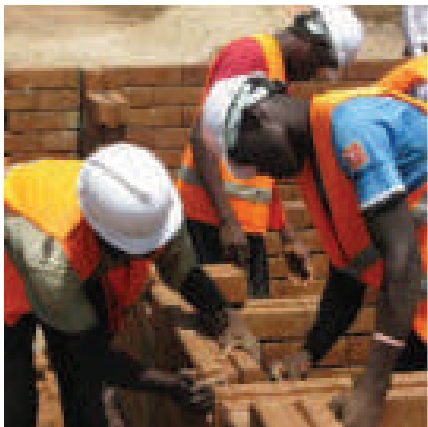
Figure 6. Mis en œuvre de blocs de terre stabilisés. © Présentation de Mauricia Nambatya à la conférence internationale MS ® IBD du 9 avril 2025, « Promotion, adoption and implementation of a climate-friendly technology – Interlocking Stabilised Soil Blocks (ISSB) for walling ».
