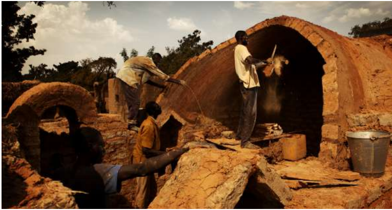
Figure 11. Construction project of the Association La Voûte Nubienne © Association La Voûte Nubienne (AVN).
