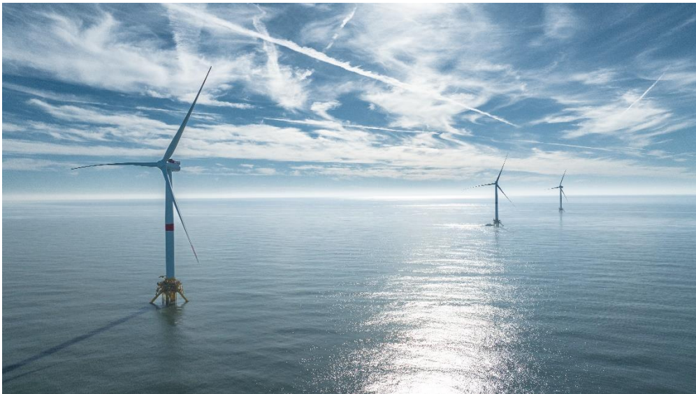
Parc éolien en mer flottant Provence Grand Large © Provence Grand Large // Prysmian
